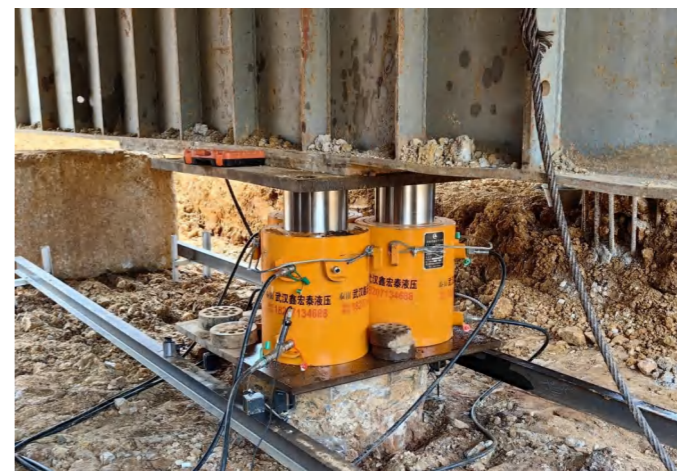
图5-2 (c) 现场位移传感器安装图
