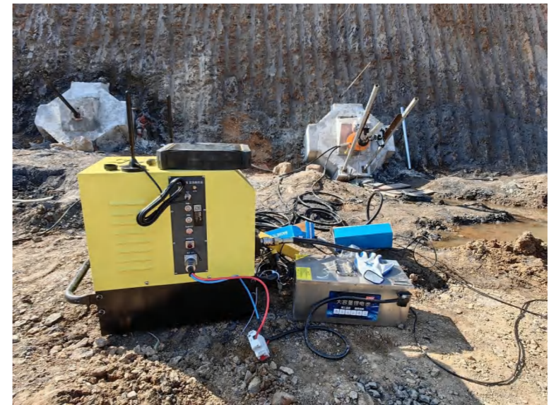
图6-2 (b) 现场一体式油泵及电池连接图
