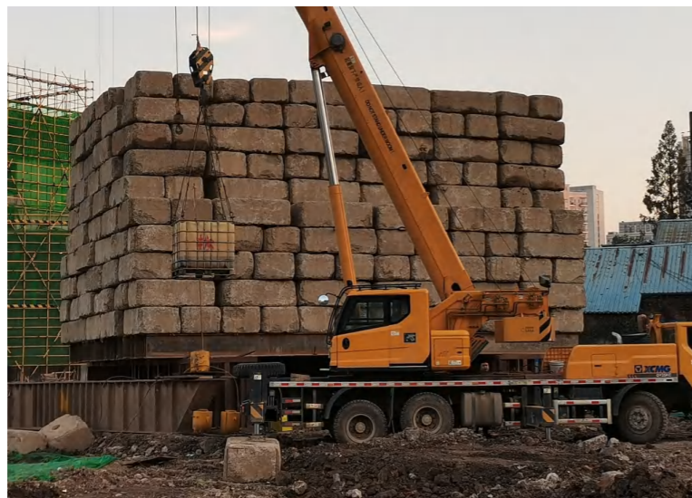
图5-2 (a) 现场反力平台图
