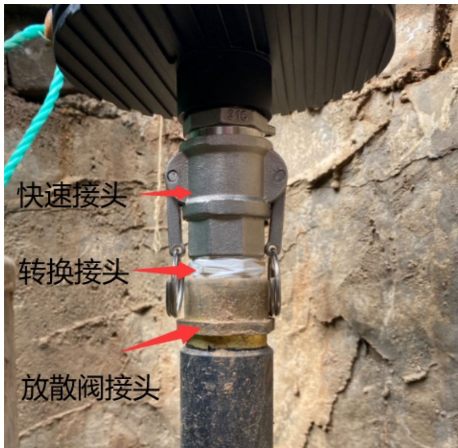
图4-3放散阀连接示意图
