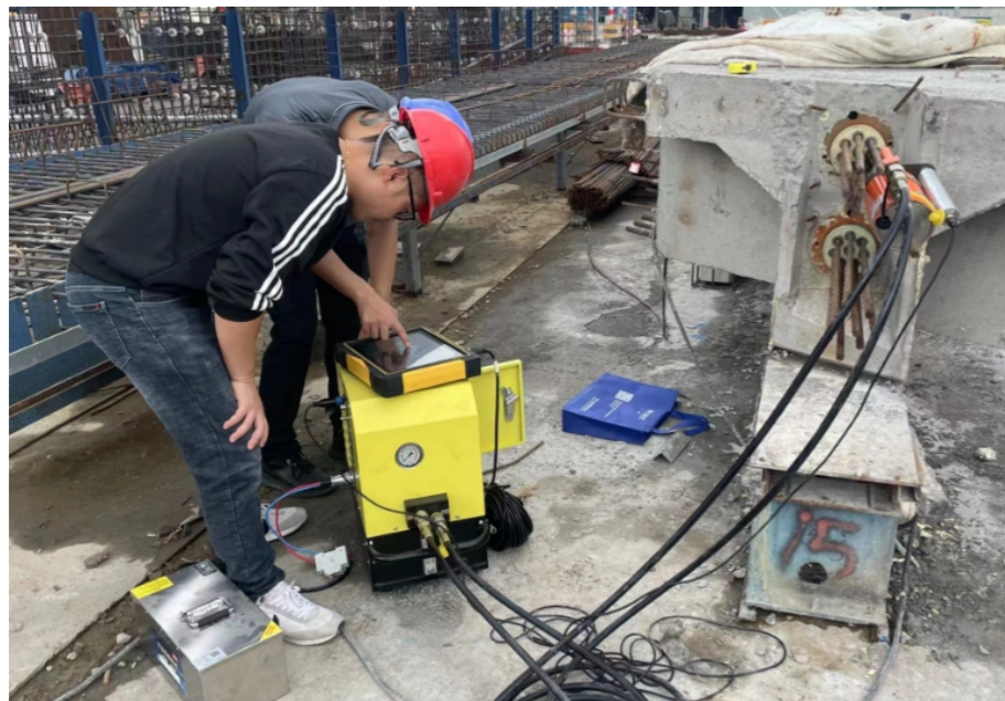
图5-3 现场油泵-千斤顶连接示意图
