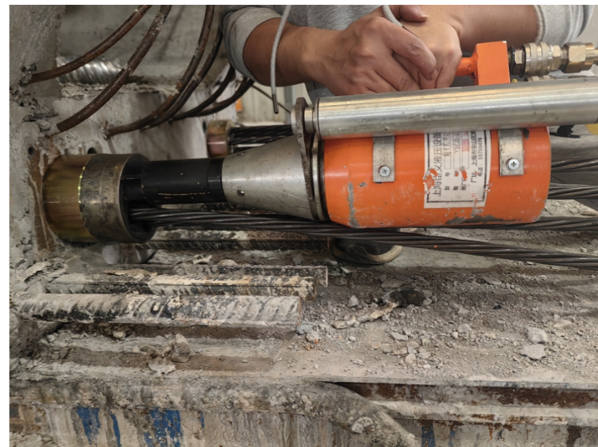
图5-2 千斤顶-锚垫板示意图
