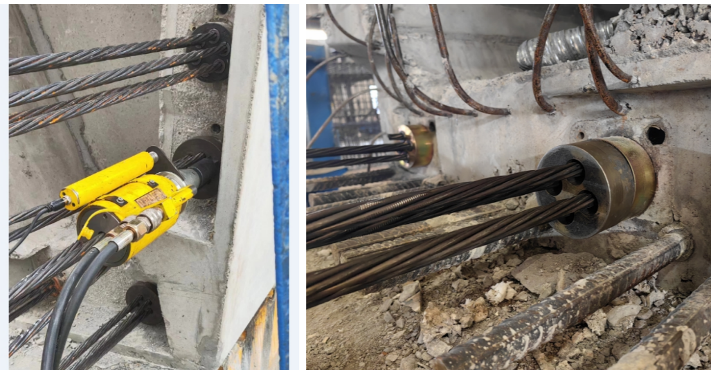
图5-1 现场预应力筋安装及未安装锚垫板对比图
