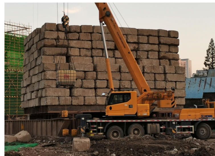
图5-2 (a) 现场反力平台图
