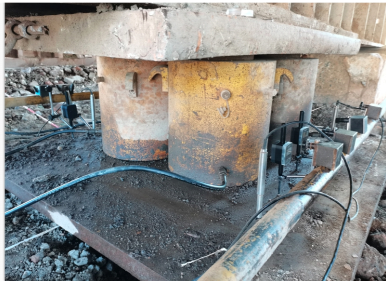
图5-2(d) 现场位移传感安装图（图中为比对试验传感器安装图）
