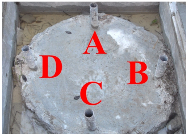
声测管编号示意图
