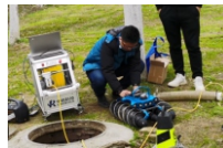
连接完成后，整体检查
