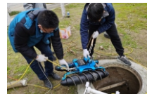
检查没问题，挂钩下吊
