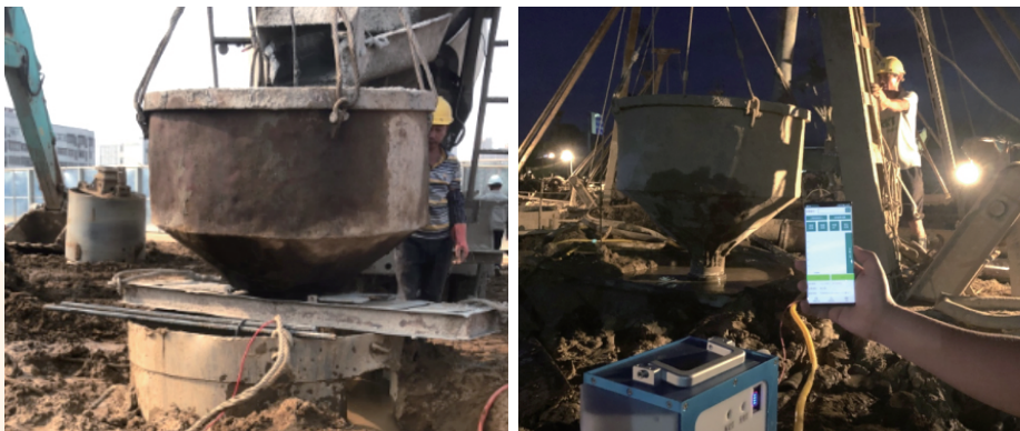
混凝土浇筑图片 ▲
